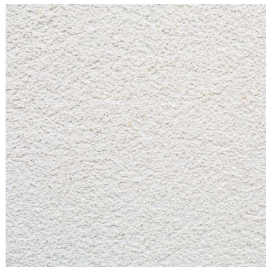
Povrch stěn z jemné štukové omítky
